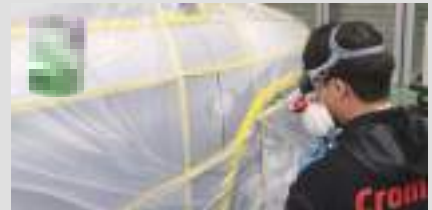
3. 표면 샌딩 후 에폭시 프라이머 도장(방청)
